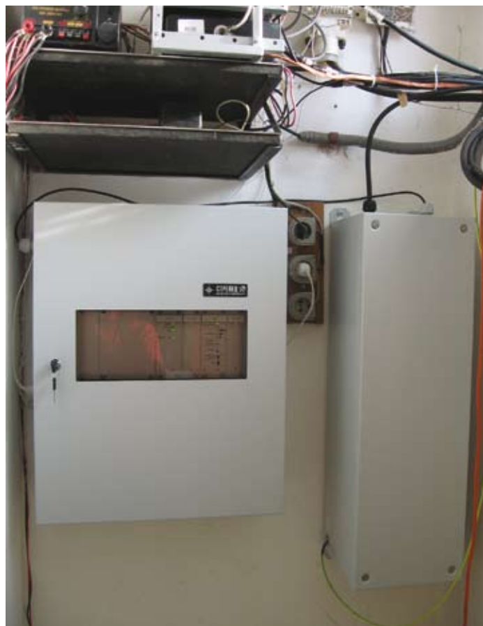
Размещение пультной станции с блоком фильтров
